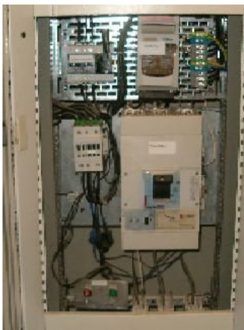
35. ábra. Nagyteljesítményű, kézi működtetésű kapcsolókészülék
