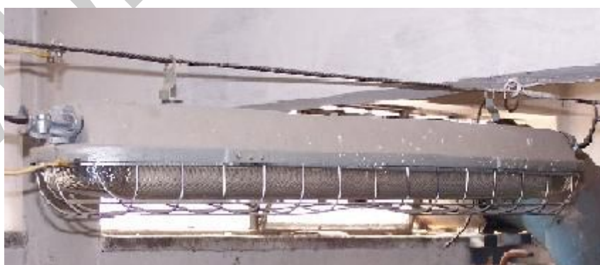
26. ábra. Feszítősdronyra szerelt fénycsöves lámpatest
