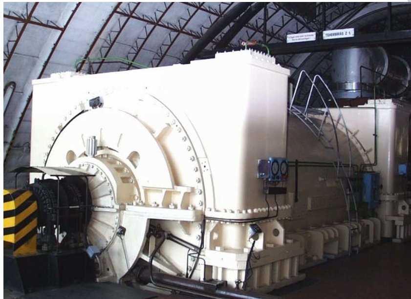
2. ábra. A Tisza II. erőmű szinkron generátora
