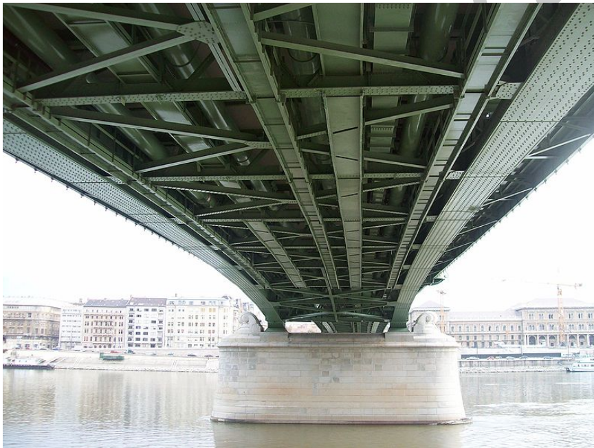
Szabadság híd alulról. Jól láthatók a szegecs sorok.
