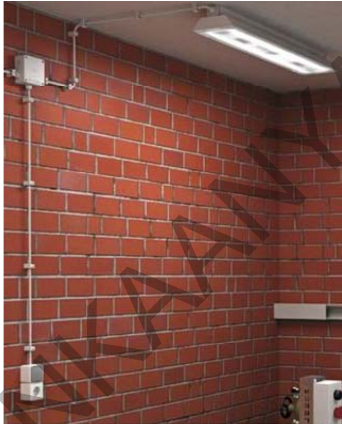
8. ábra. Köpenyes vezeték nyomvonala és szerelvényei
