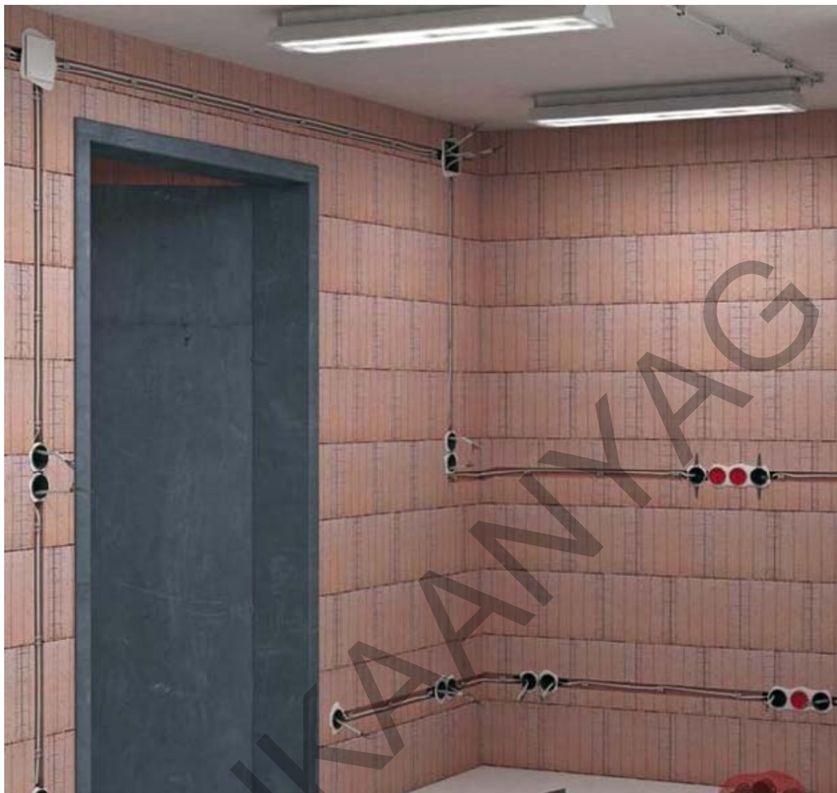
6. ábra. Vakolat alatti szerelés nyomvonala és dobozai
